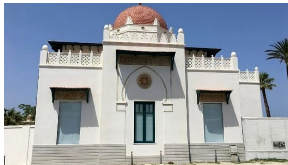
Prospetto principale dello Stand Florio di Palermo prima e dopo l'intervento di restauro.
